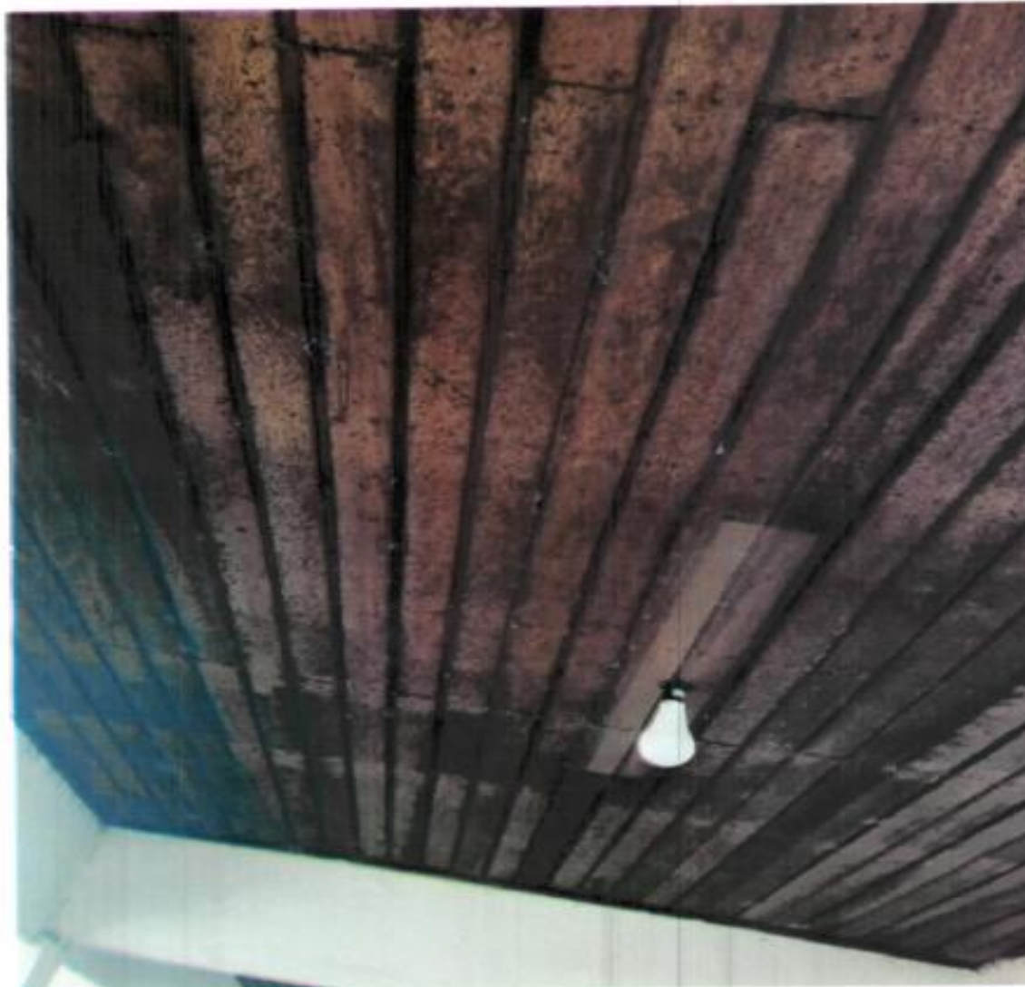
(FOTO 08) Forro de Madeira
